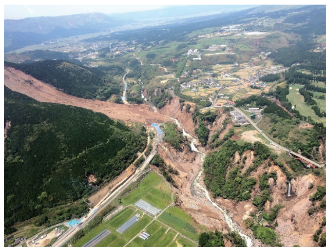
南阿蘇村の土砂災害の状況（熊本県提供）
